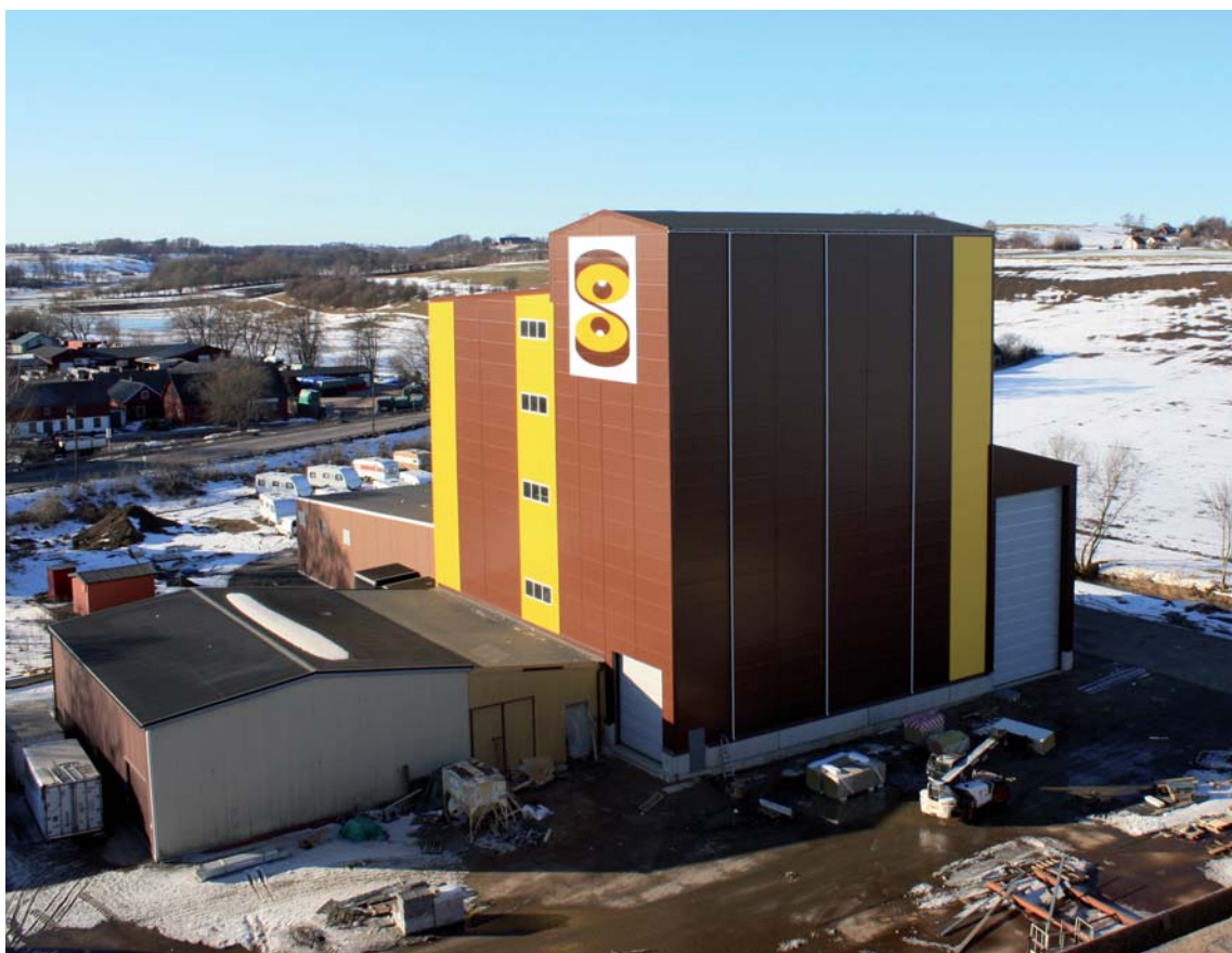
I februari 2010 står byggnaden till den nya specialfabriken klar och nu pågår maskininstallationer invändigt. I juni 2010 beräknar vi kunna göra de första testkörningarna.
